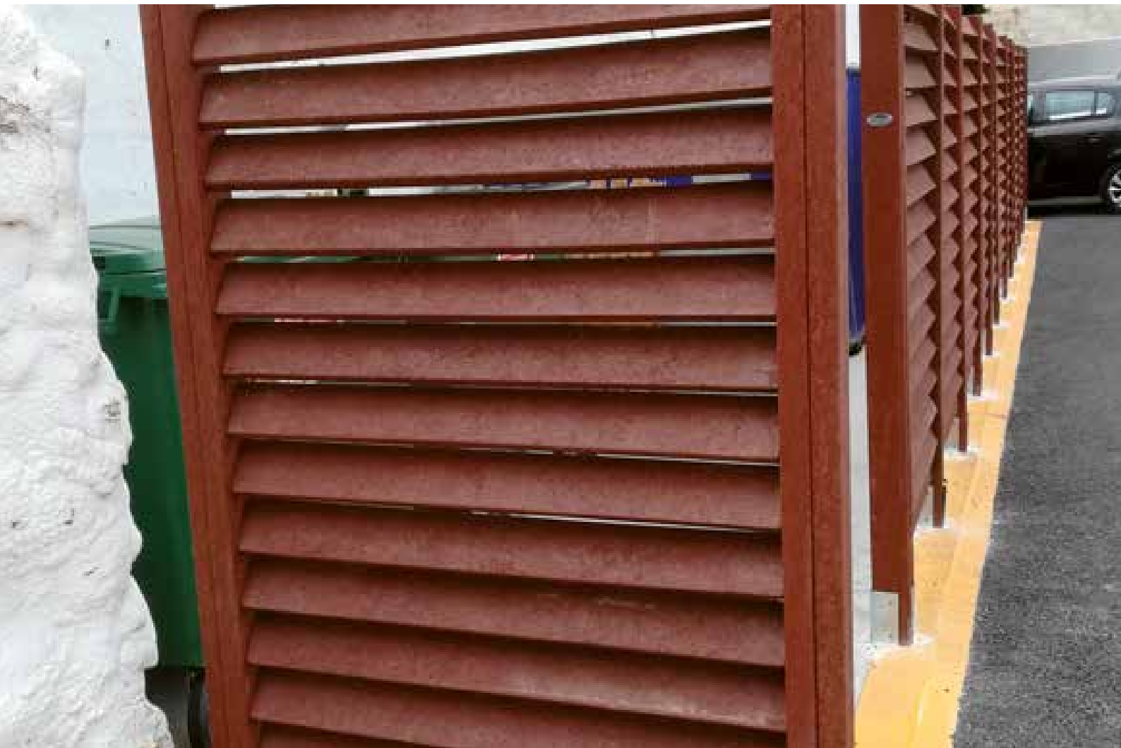
*Cubrecontenedores instalados en la localidad de Ayora.
